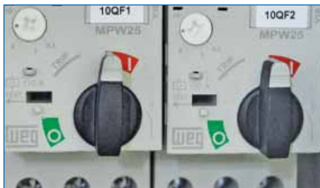
Figura 7 - Chave de partida na posição “Ligada”.
